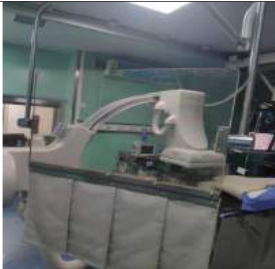
DSA 机房内悬吊铅玻璃
