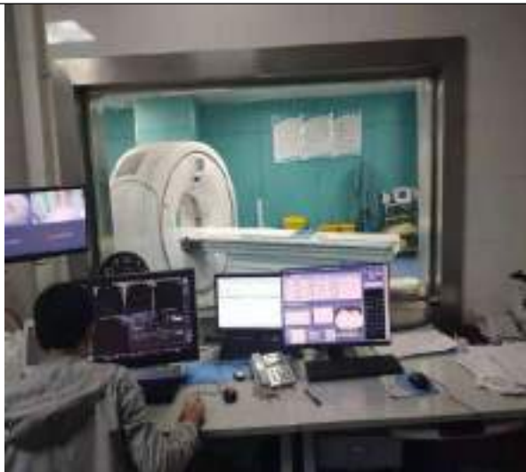
64 排 CT 机房观察窗
